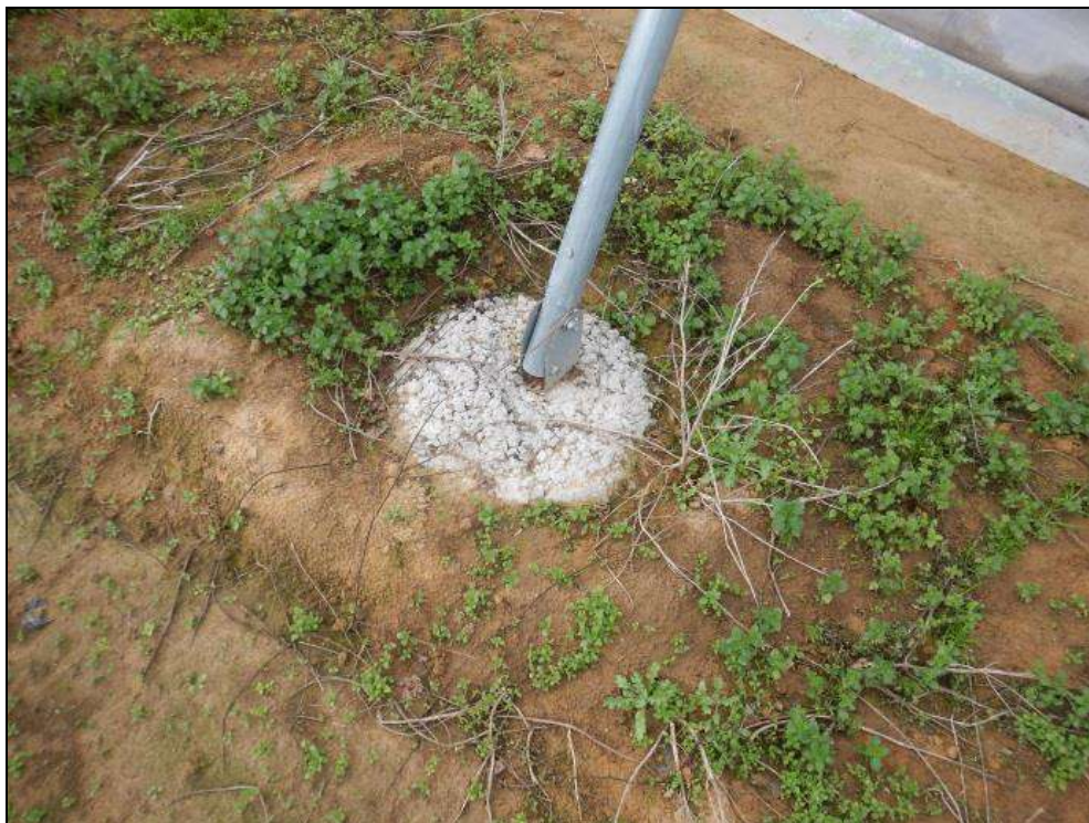
Figure 3 : Pieux d'implantation des poteaux
