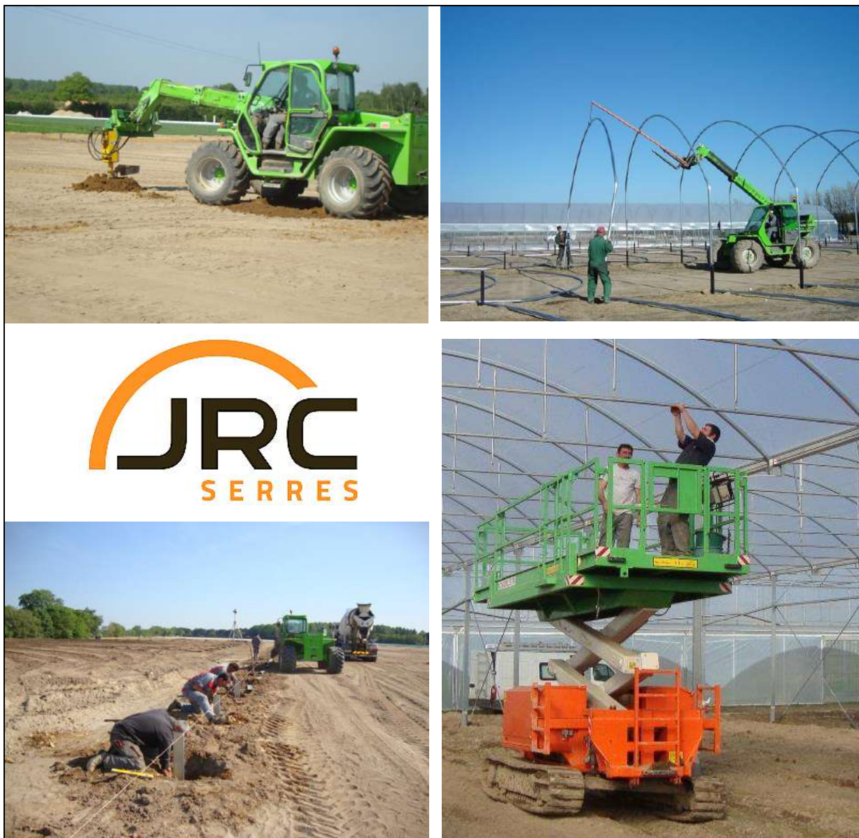
Figure 5 : Etapes de montage des serres (source : JRC serres)
