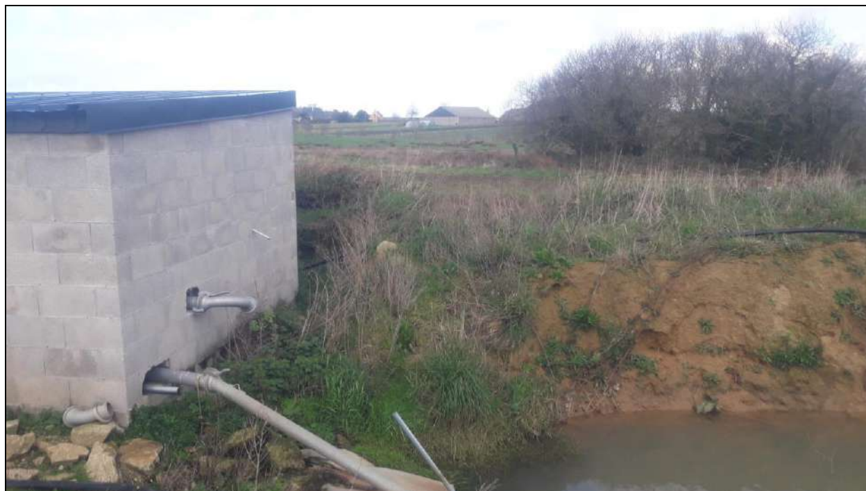
Figure 6 : Equipement de pompage (bassin 1)
