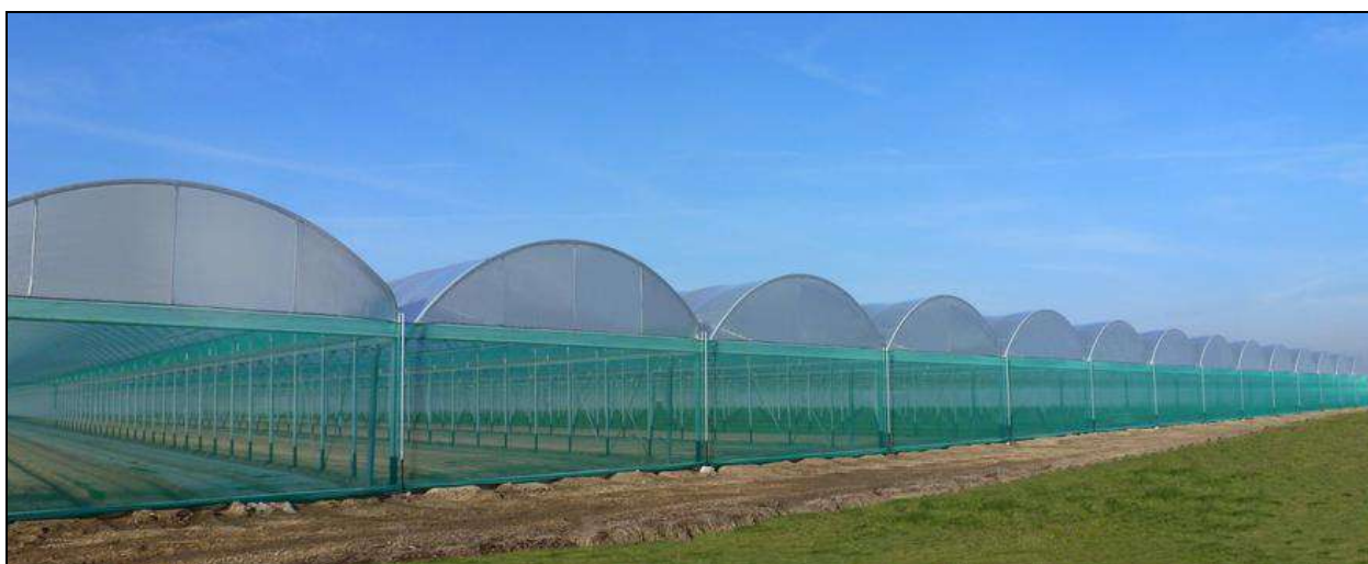
Figure 2 : Vue du pignon d'une serre composée de plusieurs nefs
