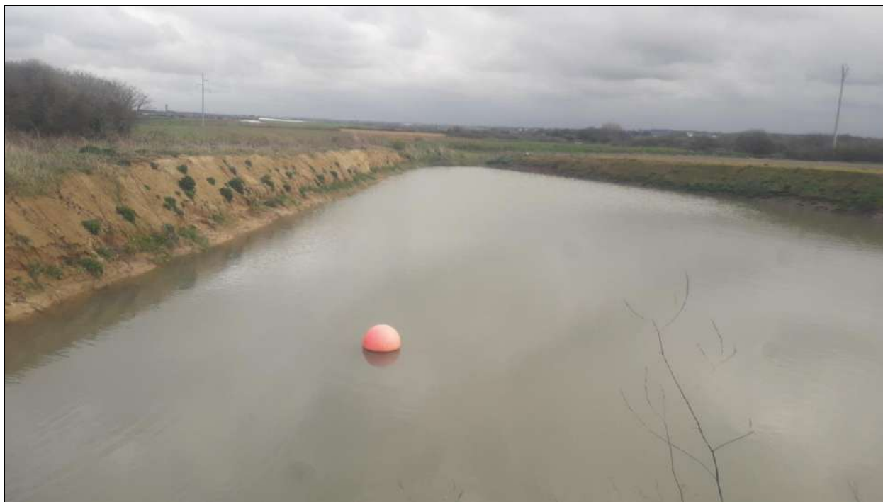
Figure 9 : Bassin 1 existant à aménager
