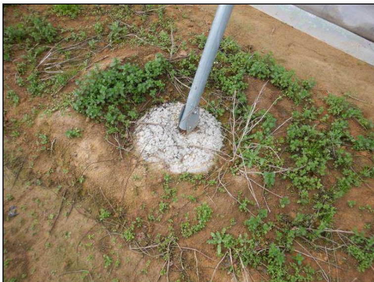
Figure 3 : Pieux d'implantation des poteaux
